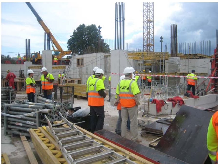
Vizītes laikā tika apmeklēts uzņēmuma “Re&Re” būvobjekts Rīgā.
