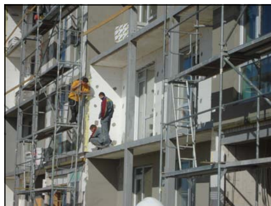
Pārbaužu laikā būvobjektos VDI konstatēja, ka darbinieki tajos strādā bez atbilstošiem individuālajiem aizsardzības līdzekļiem - aizsargķiverēm
