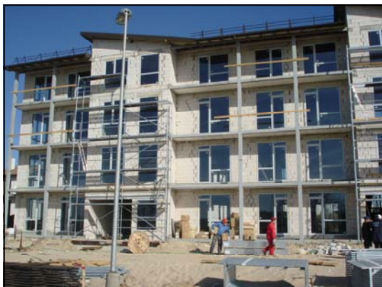
Īpaša uzmanība tiek pievērsta darbam uz sastatnēm un nožogojumiem
