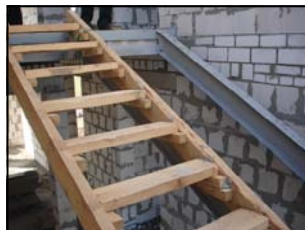
Pārvietošanās pa šādām kāpnēm apdraud darbinieka drošību
