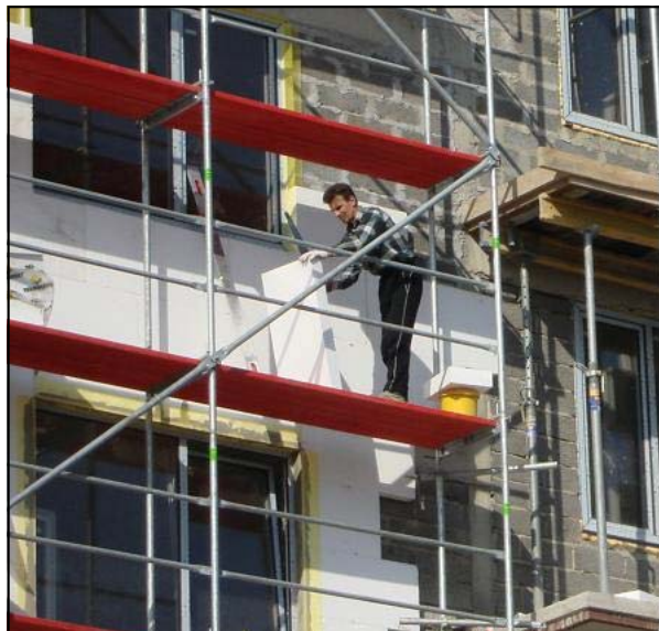
Jau pirmajās kampaņas dienās galvenā būvuzņēmēja SIA „Stārastāni” būvniecības objektā Rīgā tika atklāti vairāki pārkāpumi
