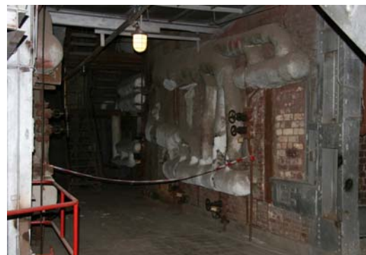
Tipiska azbestu saturoša cauruļvadu siltumizolācija Andrejostas TEC
