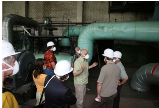
Projekta partneri un „Jaunrīgas attīstības uzņēmuma” pārstāvji apspriežas Andrejostas TEC cehā, diskutējot par pareizu azbestu saturošu materiālu demontāžu
