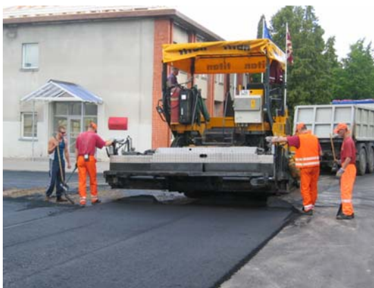
Attēli Nr. 3. un 4. Jaunais asfalta ieklājējs TITAN
