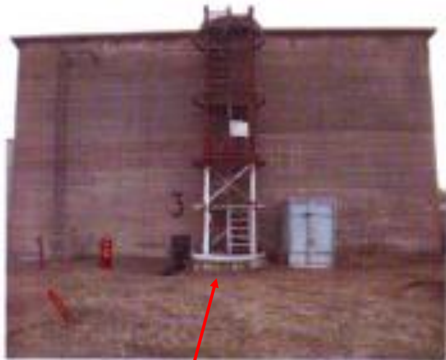
Tiltiņš, kas savieno rezervuāru Nr.3 ar rezervuāru Nr.2
