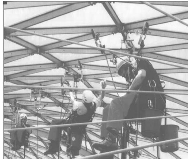
**6. piemērs. Stiklotu ātriņu un jumtu firšana no iekšpuses, izmantojot piekarināmu sēdekli (piekļuvi ar virvju un pielāgojumu palīdzību)**
