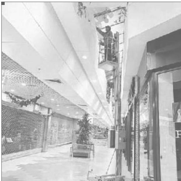
**Příklad 4:** Čištění skleněných atrií a střech zevnitř za pomocí pojízdné zdvihací pracovní plošiny s výložníkem
