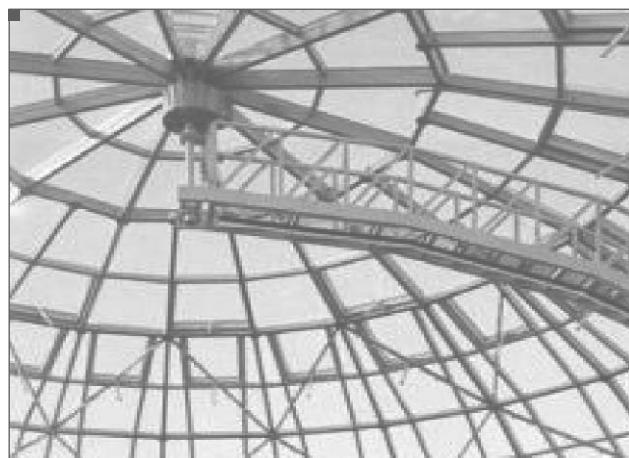
**2. piemērs. Stiklotu ātriju un jumtu fīrišana no iekšpuses, izmantojot torņveida sastatnes**
