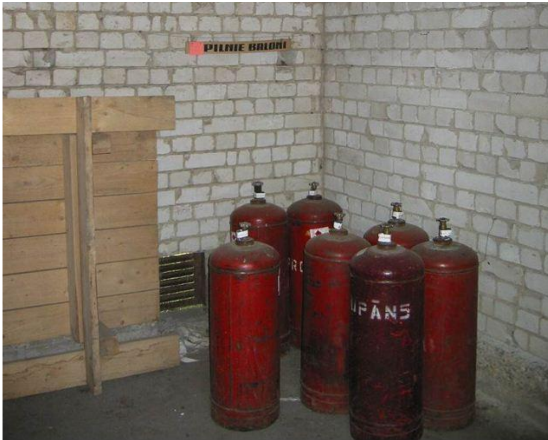
4. PIEMĒRS. Nepiemērota gāzes balonu uzglabāšanas telpas.
