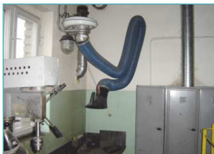
5. attēls. Lokālās nosūces ventilācijas piemērs – iespējams regulēt nosūces novietojumu tā, lai kaitīgās vielas netiktu nosūktas caur nodarbinātā elpošanas zonu.
