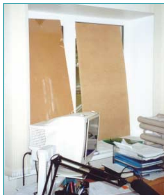
3. attēls. Biroja telpas logi aprīkoti ar nepiemērotām žalūzijām (grūti saskatāmas attēla kreisajā malā), nodarbinātie izrādījuši savu iniciatīvu – lai nodrošinātu tiešo saules staru neieklūšanu, logi aizklāti ar kartona plāksnēm.
