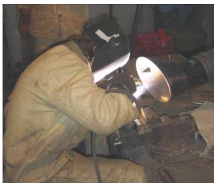
6. attēls. Noregulēta lokālās ventilācijas sistēma.
